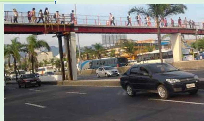
Vão central novo já instalado
