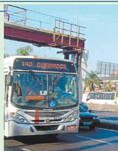
Durante a obra, sem o vão central
