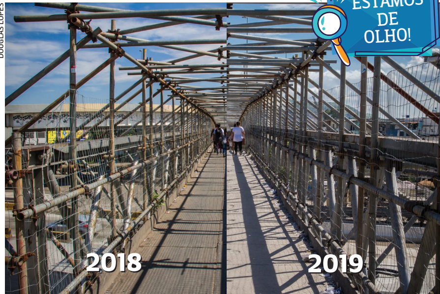
Passarela 10: piso, que era de madeira e borracha, ganhou uma camada de cimento; fiação elétrica ainda apresenta riscos
