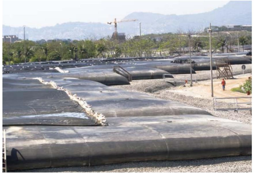
Tubos geotêxteis separam o líquido do sólido e filtram a água
