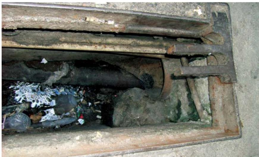
Cano de água potável passa por dentro de bueiro pluvial na Roquette Pinto
