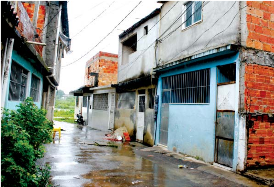
No Conjunto Esperança, as casas que podem ser demolidas...
