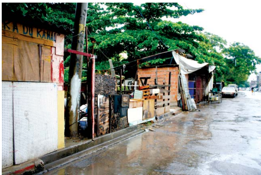
Avenida Canal, na Vila do João, também ameaçada
