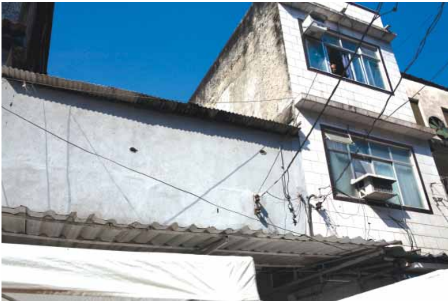
Marcas de tiros na parede das casas após a incursão de 2 de maio
