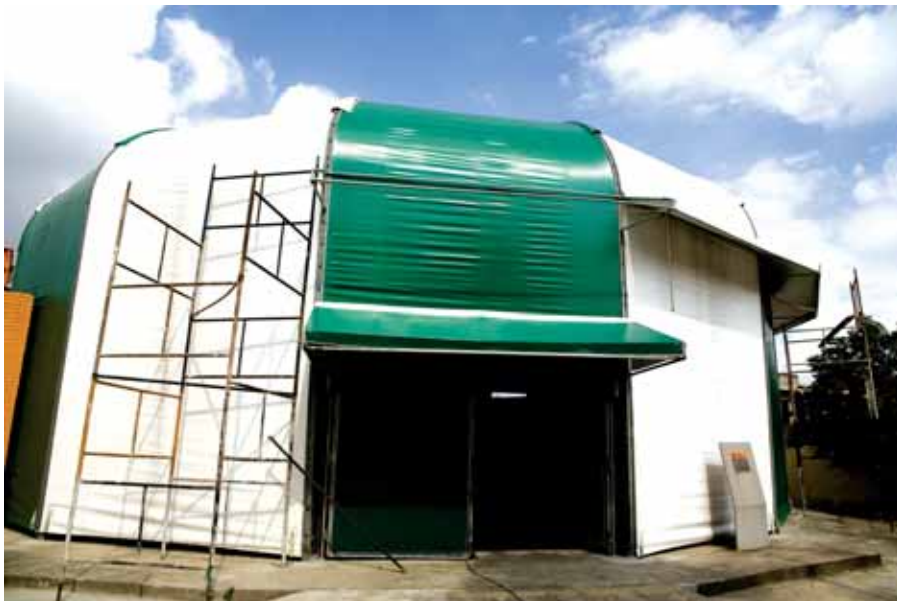
Acima, o espaço em fase final de obras, já de lona nova
