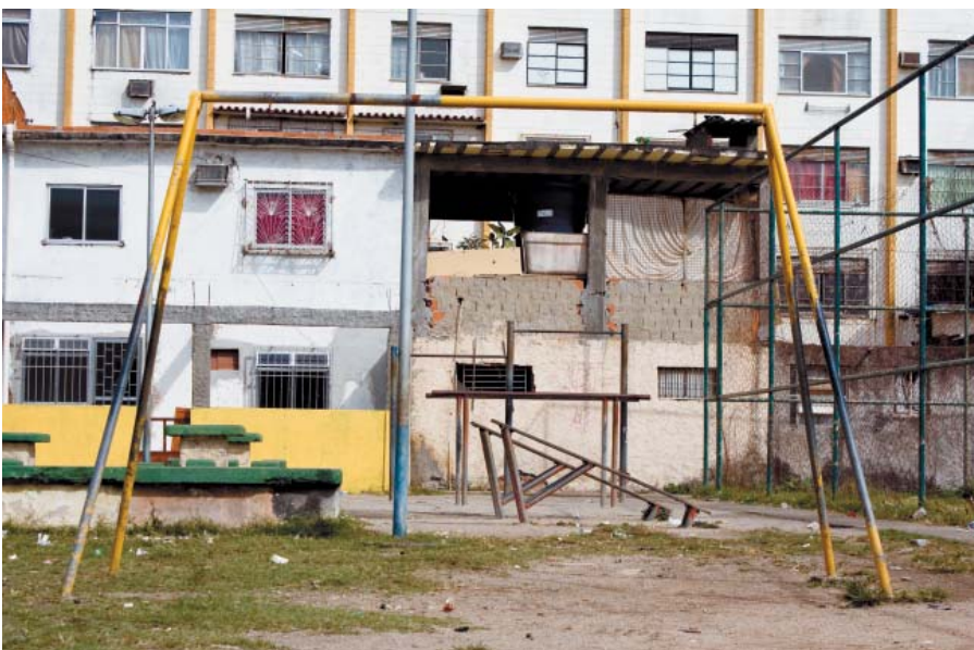
Balanço quebrado no Conjunto Esperança
