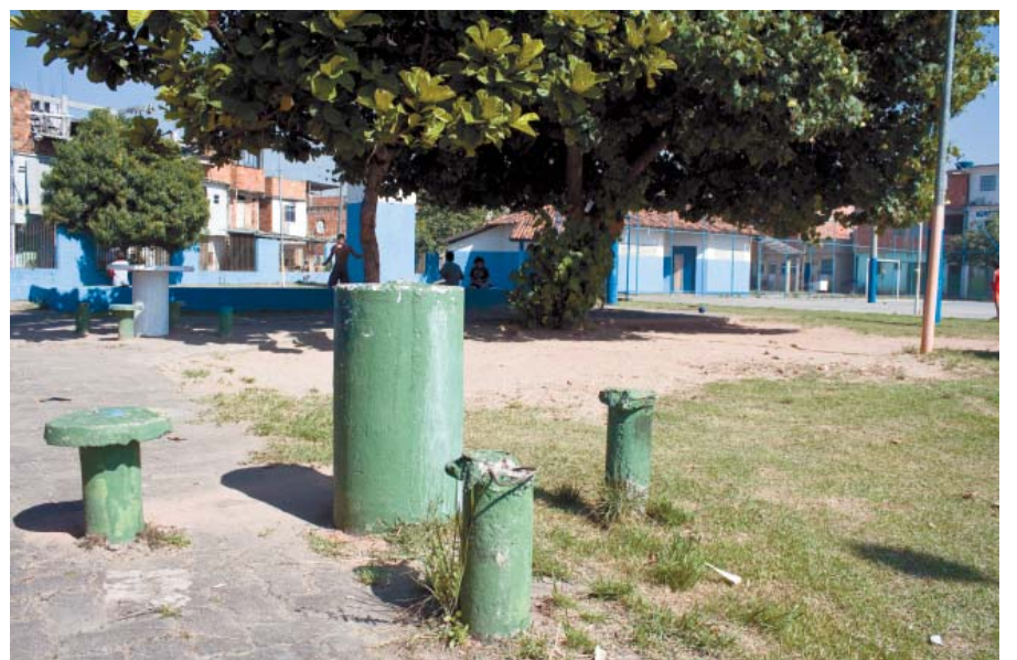
Bancos destruídos na Roquete Pinto
