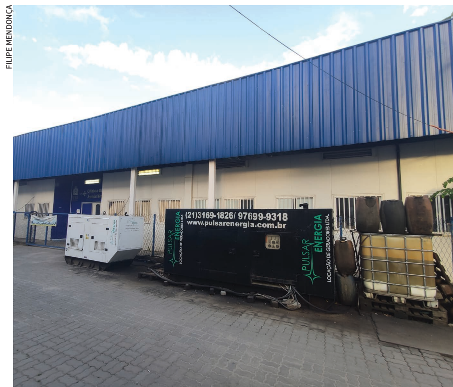
A clínica da família, que atende a três favelas da Maré, fechou as portas por falta de combustível do gerador
