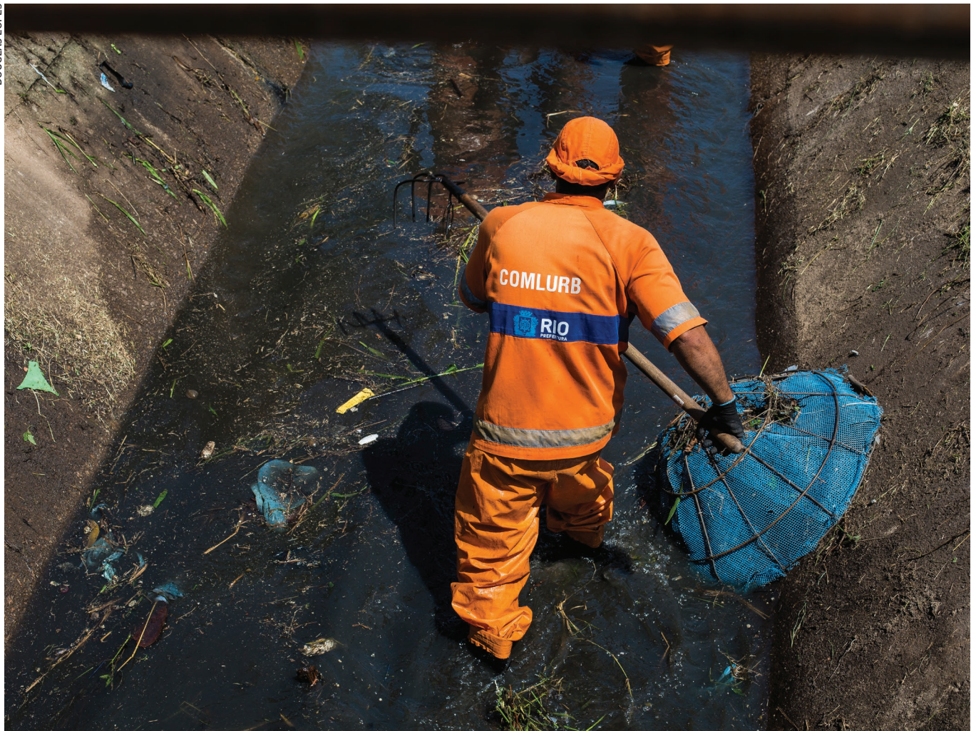
Além da coleta de lixo e varrição de ruas, garis realizam uma série de outros trabalhos, como a remoção de resíduos de encostas
