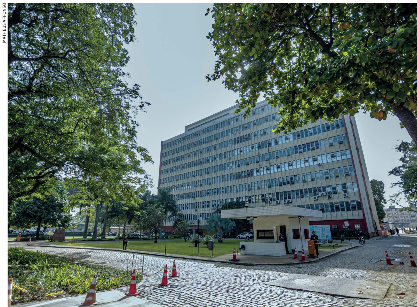
Prédio da Expansão (ao lado do Conjunto Esperança), onde funcionam instalações das áreas administrativas e de pesquisa, faz parte do Campus Fiocruz Maré
