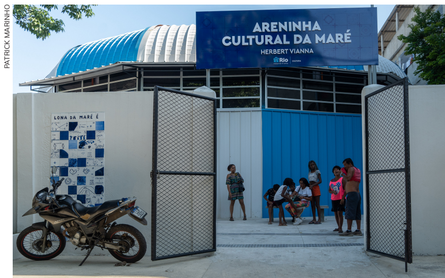
Depois de um ano de obras, a Areninha Hebert Vianna reabriu para o público
